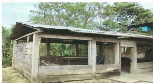
Foto 9: Cambio de pared de madera a block .
