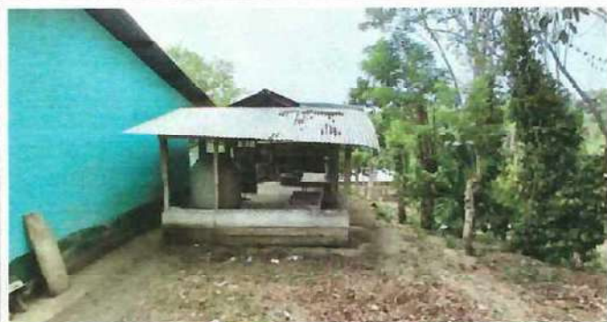
Foto 7: COCINA: Cambio de techo a lámina troquelada.
