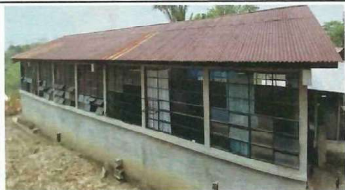
Foto 1: CUBIERTA DE LÁMINA Y ESTRUCTURA: Cambio de láminas y mantenimiento de estructuras metálicas.
