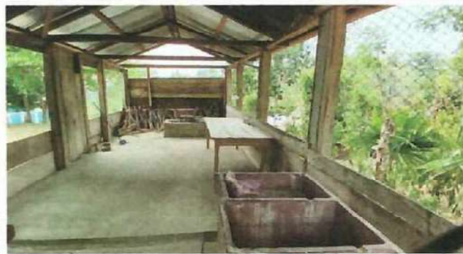
Foto 8: Cambio de estructura de madera a metal.
