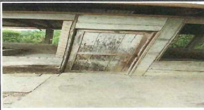
Foto 10: Cambio de puerta de madera a puerta de metal.
